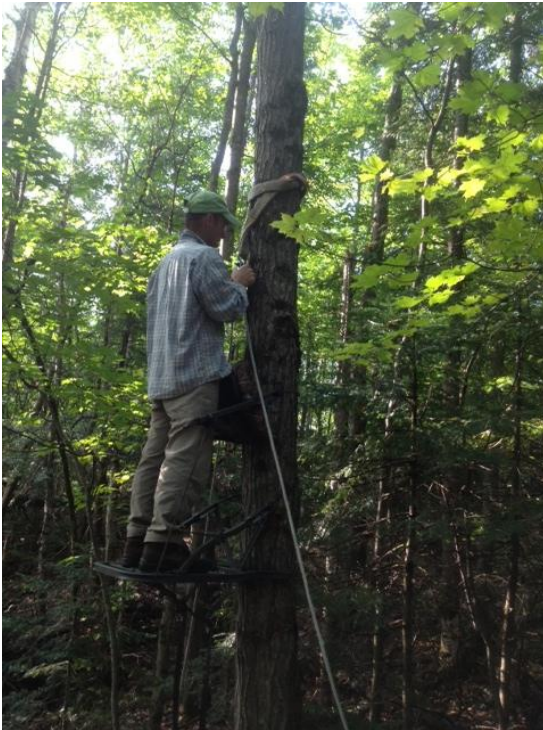
Figure 5: Utilisation du siège auto-grimpant pour installer le câble sur l'arbre aval-pivot
