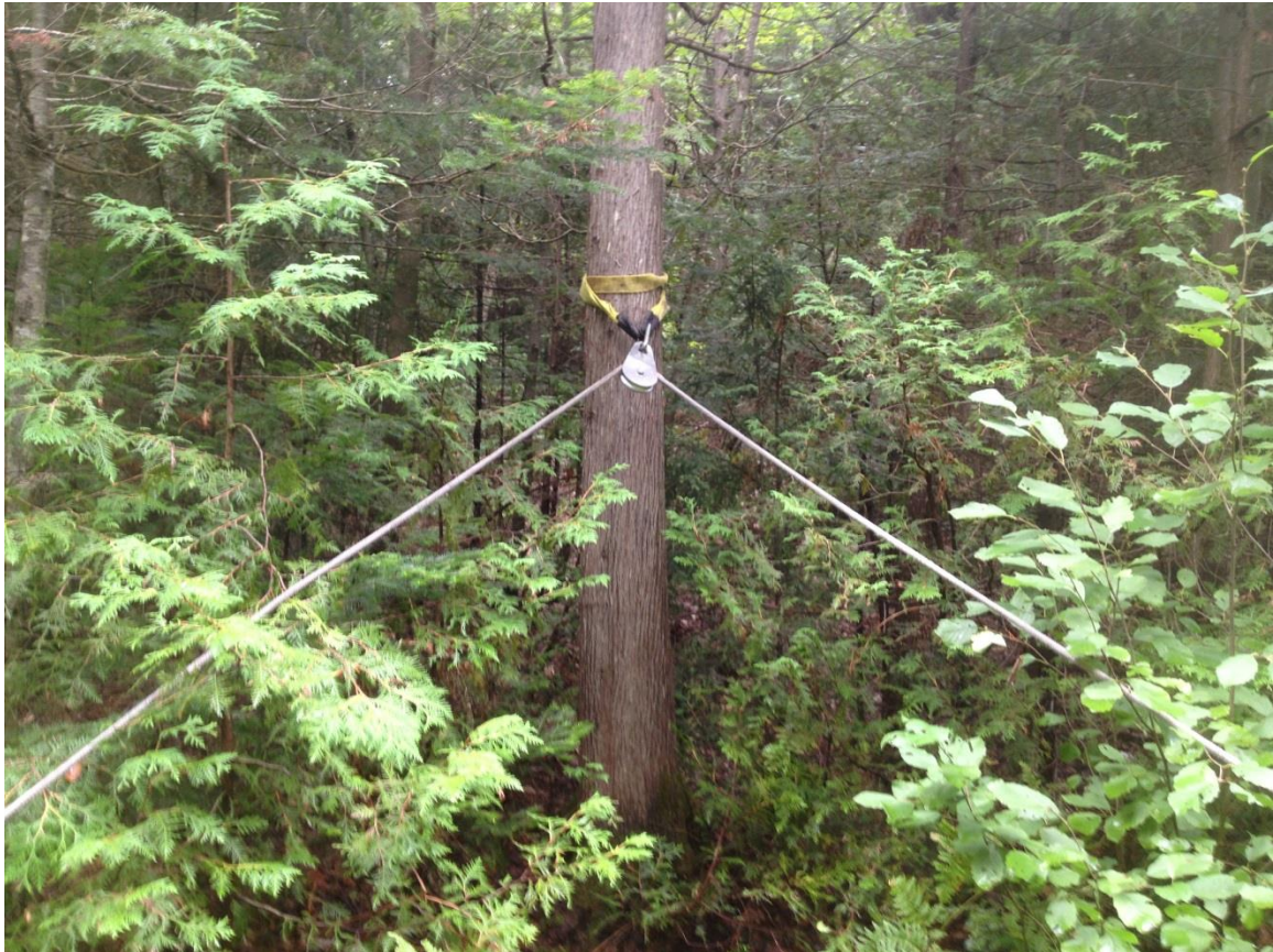
Figure 6: Installation d'une poulie en hauteur pour le halage des billots. À gauche, le câble est attaché au billot que l'on désire apporter sous la tyrolienne; à droite, le câble est attaché au Portable Winch
